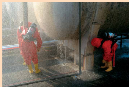
设备检查与堵漏
